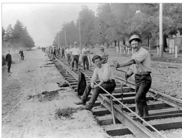
Рис. 1 Мельбурнские шахтёры строят линию для облегчения транспортировки тяжёлых грузов [1]
