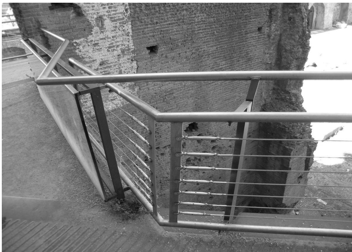
Рис. 93. Гибкость в использовании стандартных изделий сортамента металлических профилей, стальных листов и тросов. Устройство в нач. 1990-х гг. открытой галереи, примыкающей к Дому родосских рыцарей и включённой в экспозиционный маршрут форума Траяна в Риме. Фото автора, 2006
