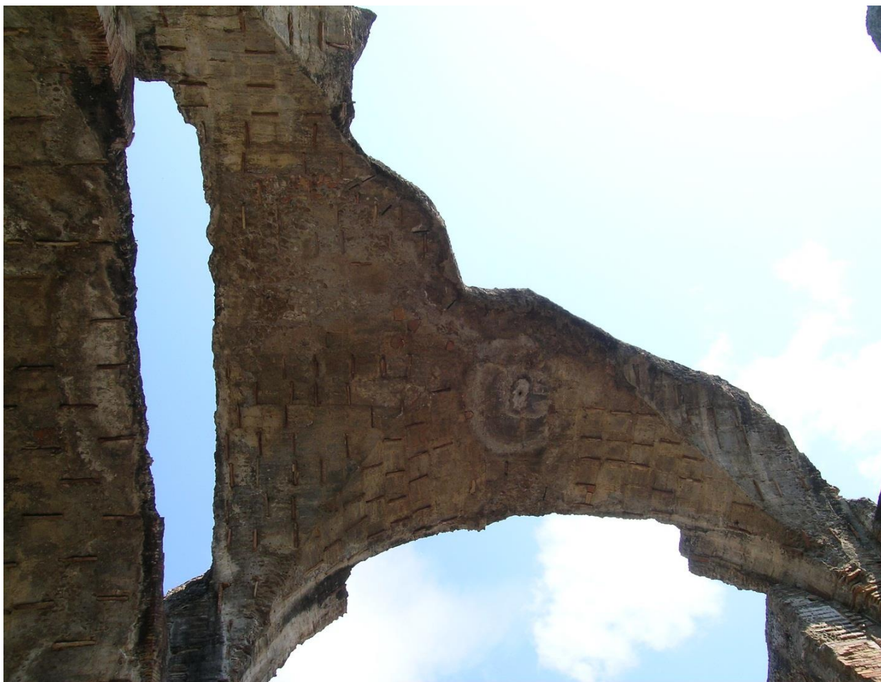
Рис. 40. Введение конструкций для поддержания свода терм на вилле «Адриана» в Тиволи (Италия). Фото автора, 2005
