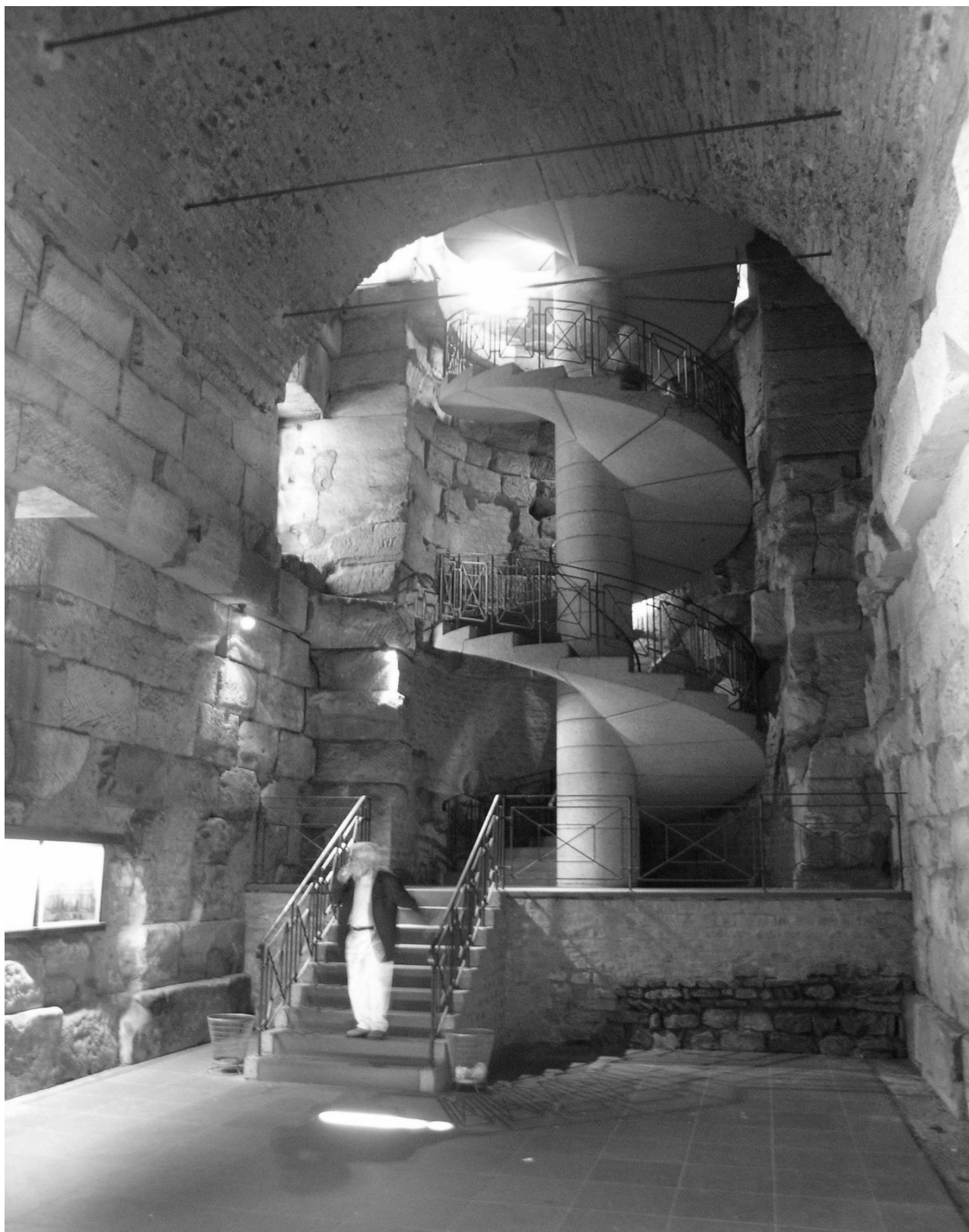
Рис. 28. Организация подъёма на видовую площадку. Винтовая железобетонная лестница, ведущая на верхний ярус ворот Порте Нигро. Трир, Германия. Фото автора, 2003
