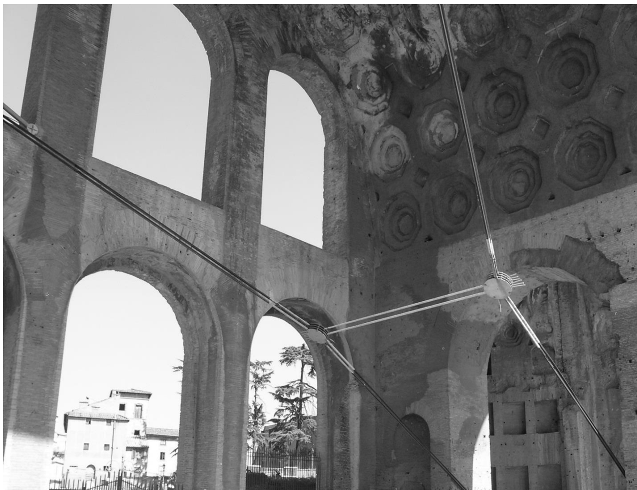
Рис. 44. Кинестезически-жестикулятивное воздействие элементов усиления конструкции руин базилики Константина-Максценция (Рим, 2000-е гг.). Фото автора, 2009
