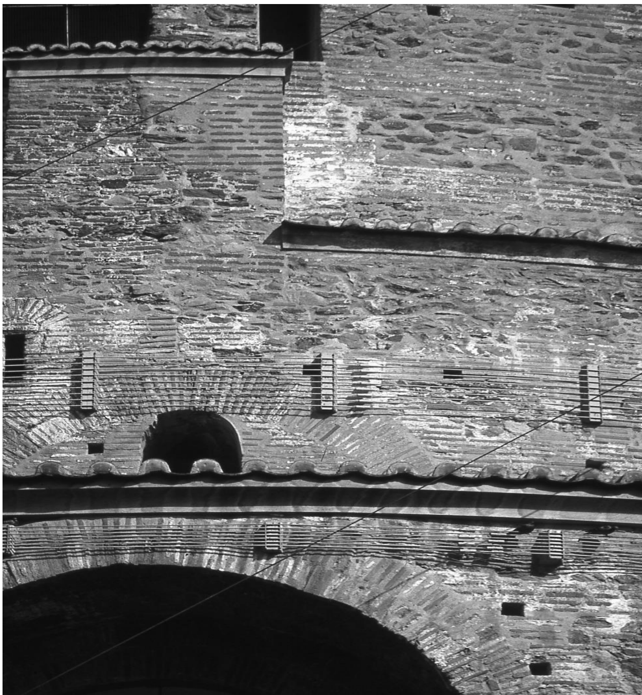
Рис. 43. Минимизация визуального воздействия новых конструктивных элементов комплекса. Система обжимающих вант, противостоящих распору купола так называемой "гробницы Галерия" (г. Салоники, Греция). Фото автора, 2001
