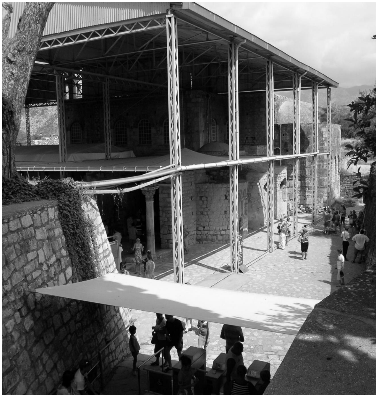
Рис. 25. Создание системы металлического каркаса и светопропускающих тентов для экспонирования руин храма Св. Николая (город Демре, Турция) Турция. Фото автора. 2009
