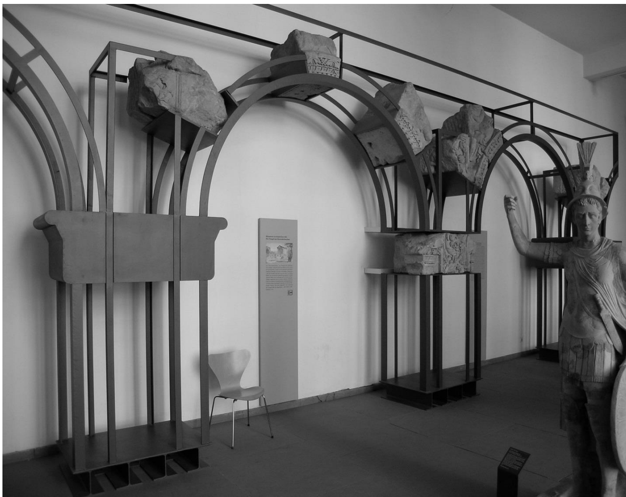
Рис. 32. Восстановление пространственной взаимосвязи архитектурных фрагментов использованием несущей конструкции из стального металлопроката в экспозиции Рейнского национального музея, г. Трир (Германия). Фото автора, 2003
