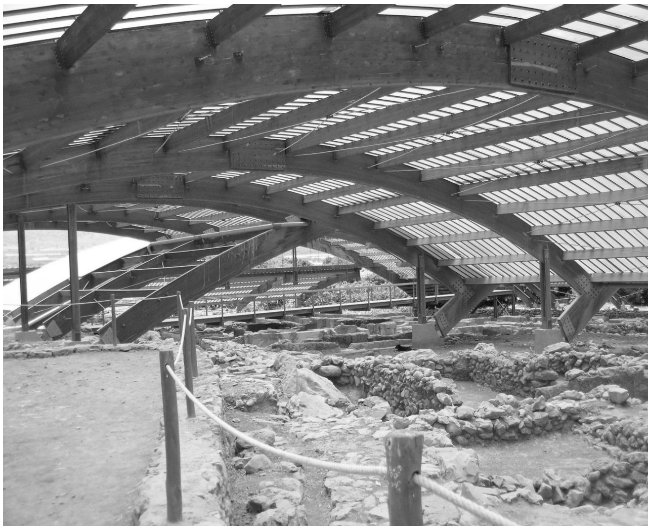
Рис. 45. Создание ритмически и пластически нейтрального фона экспозиции использованием большепролётной конструкции. Навесы над руинами дворцов города Малья на острове Крит. Фото автора, 2006
