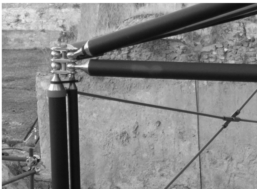
Рис. 96. Исходные базовые элементы конструктора: стержень и связующий узел с резьбовыми соединением. Навес над участком Императорского форума. Рим. Фото автора, 2017
