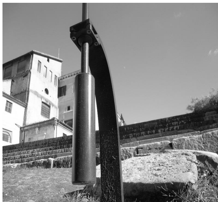
Рис. 81. Достижение определённого проектом наклона (в частности, вертикальности) опоры и носителя текста. Римский форум: a – рамная конструкция опоры (без заделки в грунт) и информационного щита. Рим. Фото автора, 2017; б – опоры с регулируемыми винтами в основании. Рим. Фото автора, 2017; в – противовес и регулирующие винты в основании несущей конструкции информационного щита. Рим. Фото автора, 2017
