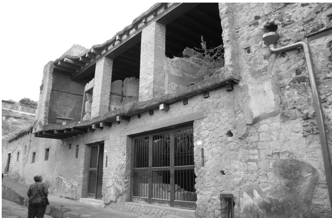
Рис. 47. Создание системы водоотвода археологического заповедника в Геркулануме. Италия: a – создание перекрытий, кровель, водосливов и системы удаления поверхностных вод в перистильном дворе жилого дома Casa del salone Nero . Фото автора, 2009; б – создание перекрытий, кровель и устройство наружного водостока. Фото автора, 2009
